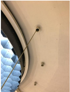
Dakdoorvoer vanuit binnen
