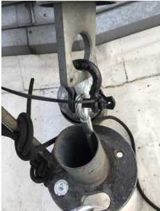
Dakdoorvoer met montage kabel
